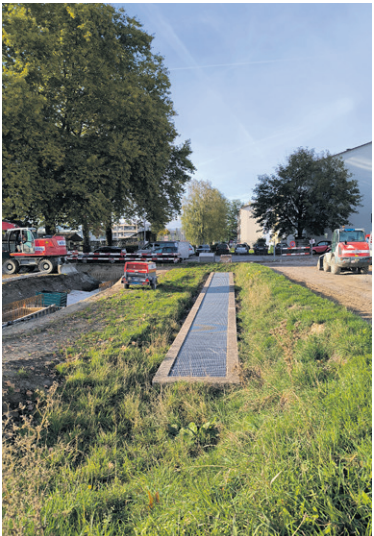
Der Schachtkopf des Filterschachtes als sichtbarer Teil der Anlage
