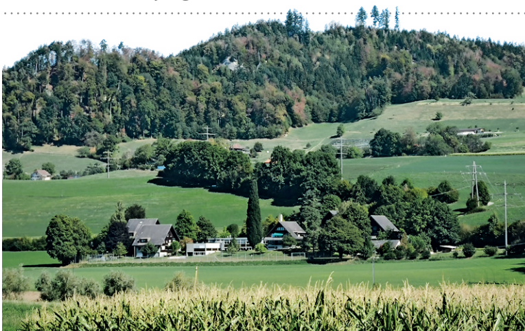
Fernsicht von der Umfahrungsstrasse auf die Gebäude und das Areal der BEObachtungsstation Bolligen
