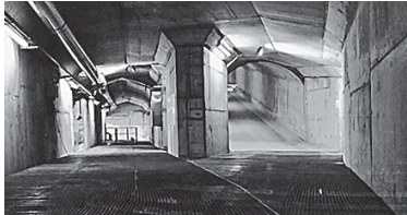
Der Versorgungsstollen dient der Überwachung der Deponie auch nach deren Rekultivierung
