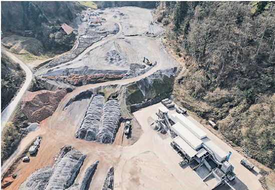
In der Entschrottungsanlage werden in der Schlacke vorhandene Metallteile zurückgewonnen
