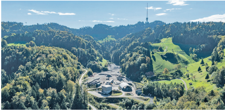
Blick auf die Deponie Laufengraben. Hier werden Schlacke und Filterasche über Jahrzehnte kontrolliert und überwacht gelagert
