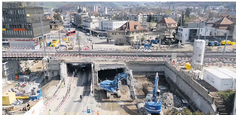
Blick in Richtung Norden auf die Bauarbeiten an der Unterführung Bernstrasse
