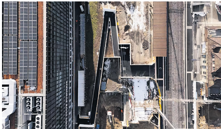
Die neue Zugangsrampe zum Mittelperron aus der Vogelperspektive
