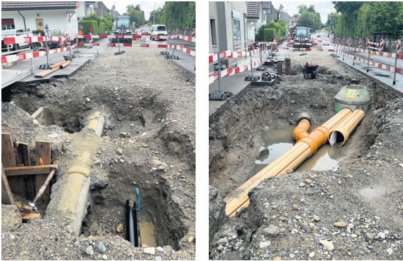
Blick in den Untergrund der Bernstrasse: Die alten Zementleitungen der Strassenentwässerung (links) werden durch Kunststoffrohre (rechts) ersetzt. (Bild: A. Gygli)
