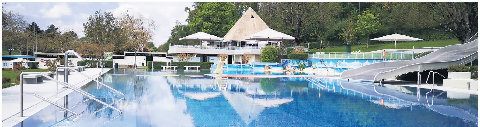
Ein Problempunkt in Freibädern bei überdurchschnittlicher Auslastung während Hitzeperioden ist die Einhaltung der THM-Werte, denn ein Zuviel an Trihalogenmethanen ist gesundheitsgefährdend; THM entsteht u.a. als Nebenprodukt von Chlor-Desinfektionsmitteln
