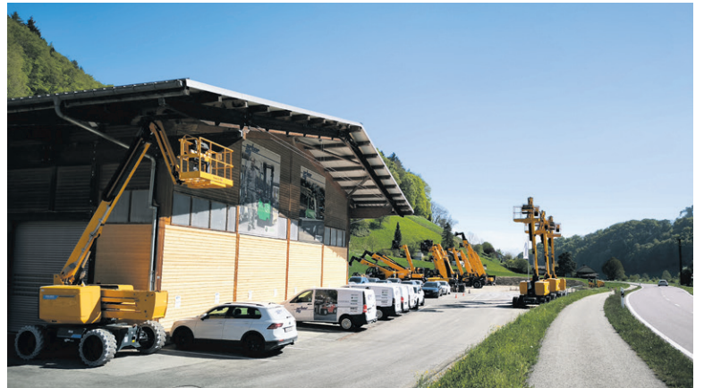
Der Parkplatz der Arbor AG und die anschliessende temporäre Installationsfläche
