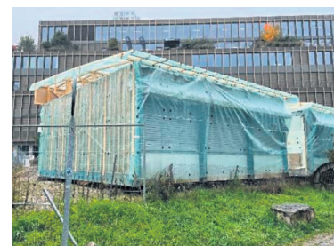
Der Pavillon im Zwischenlager
